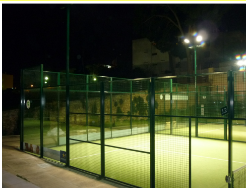
PISTA Nº12 EQUIPADA CON 8 LUMINARIAS LEDS
